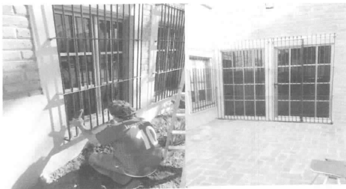
LIMPIEZA GENERAL DE LA OBRA PARA ENTREGA
