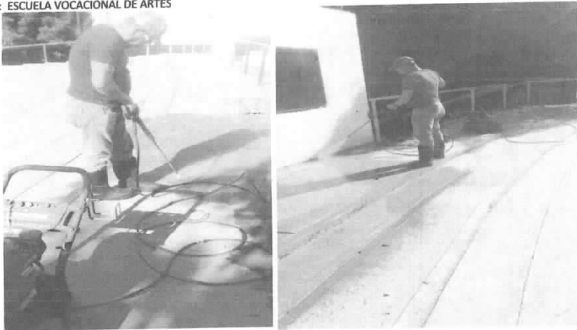
LIMPIEZA DE PISO DE CONCRETO.
