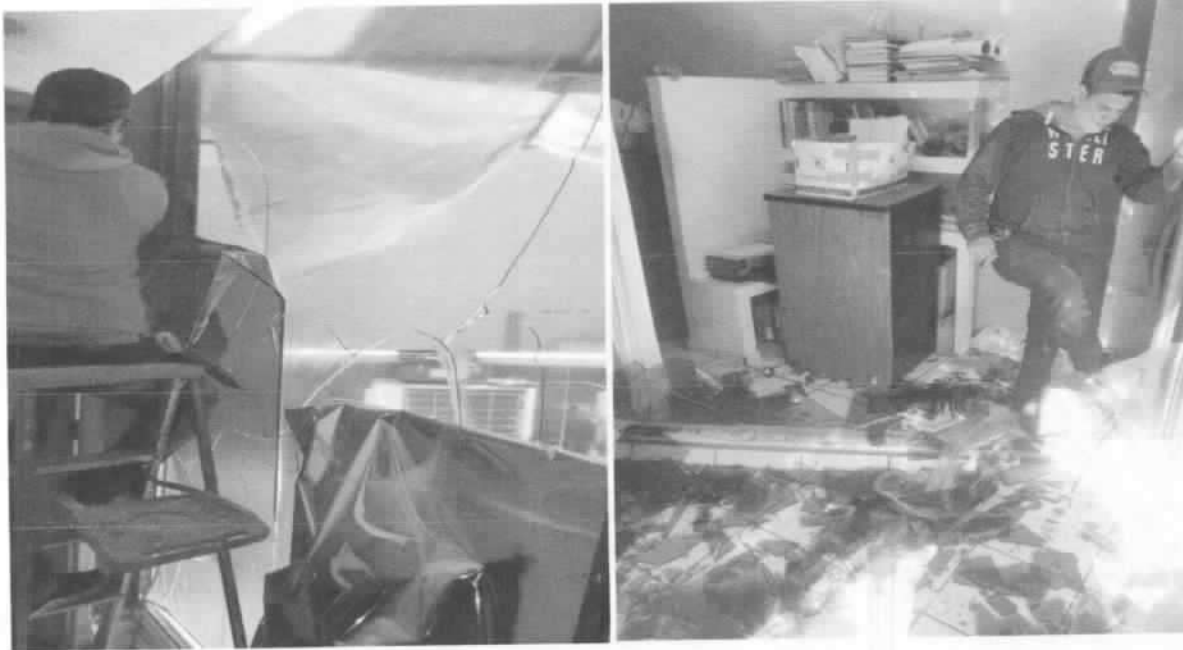
DESMONTAJE DE VIDRIOS, CRISTALES
