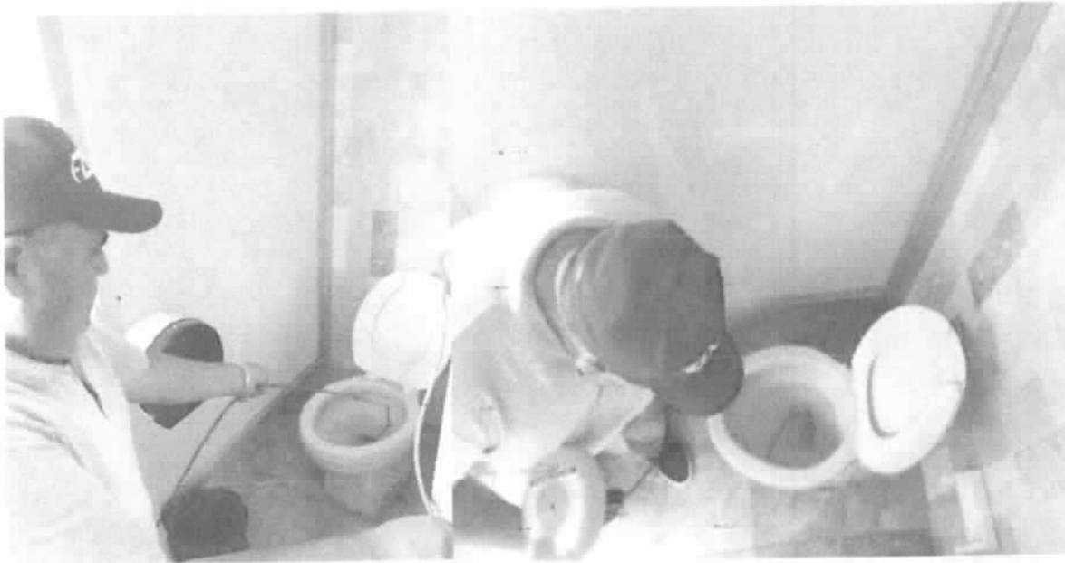
SONDEO, DESAZOLVE Y LIMPIEZA DE MUEBLES SANITARIOS EN BAÑOS.
