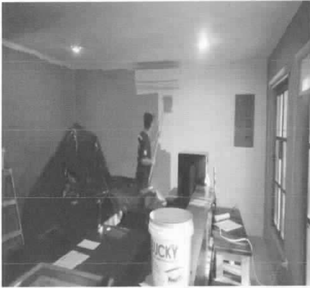
PINTURA VINILICA LAVABLE EN MUROS, COLUMNAS, TRABES Y PLAFONES
