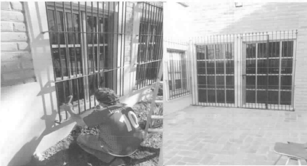
LIMPIEZA GENERAL DE LA OBRA PARA ENTREGA
