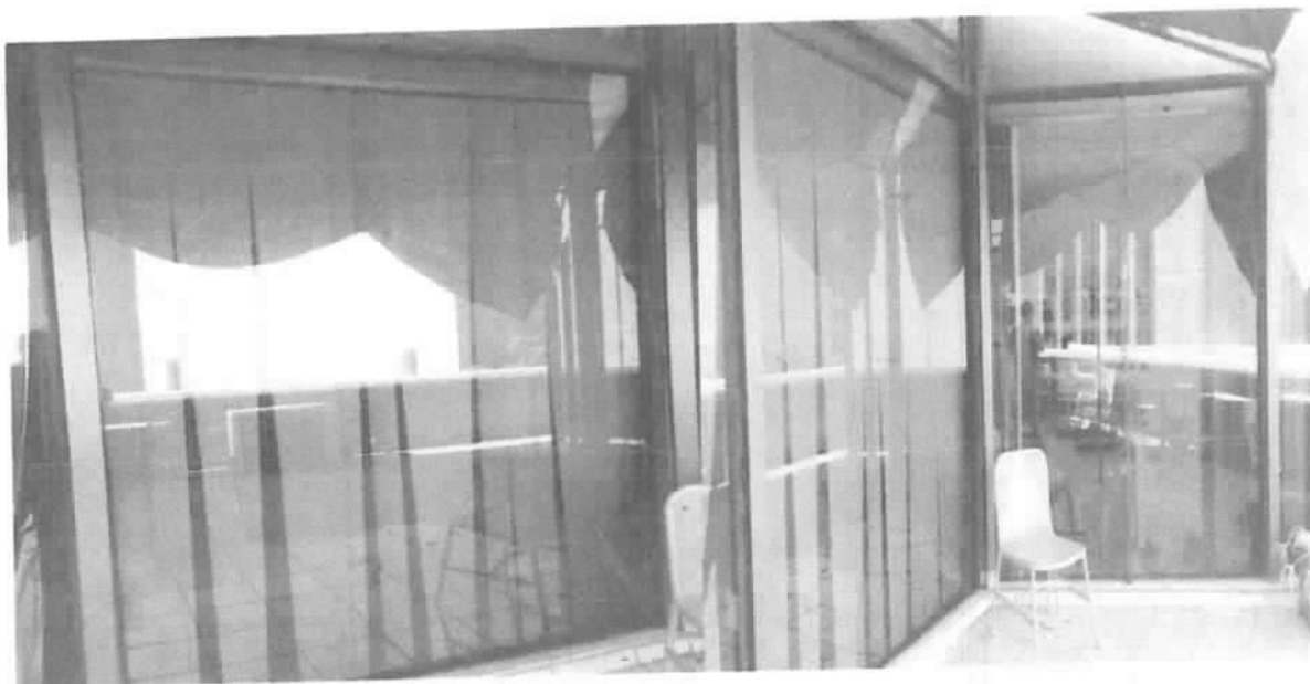
SUMINISTRO Y COLOCACION DE CRISTAL.
