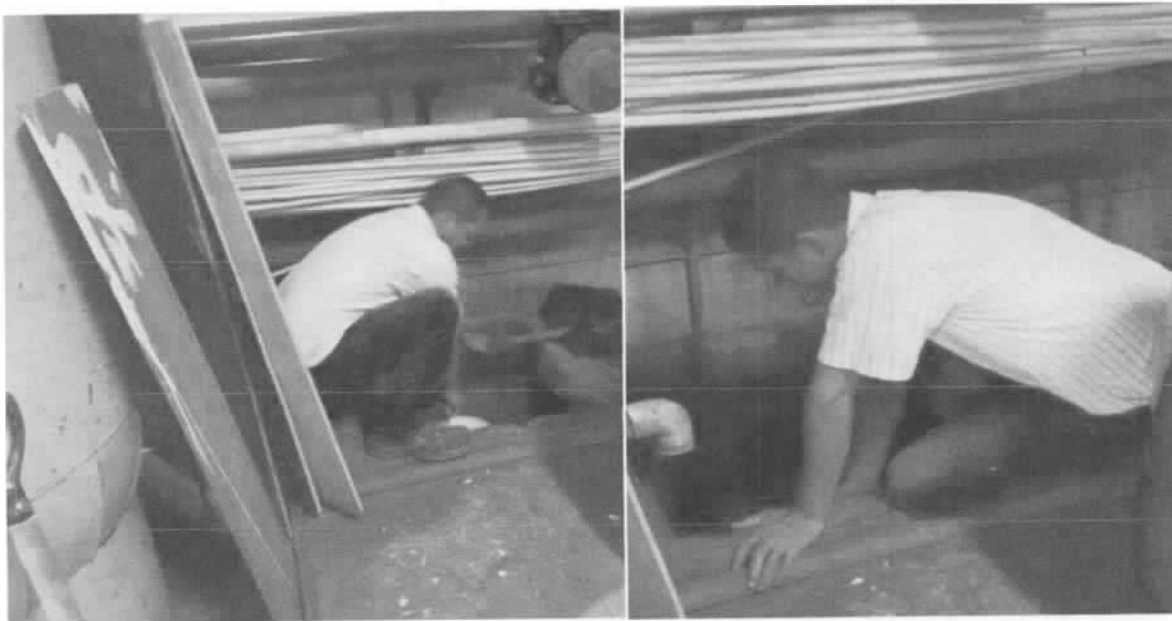
LIMPIEZA DE CISTERNA.
