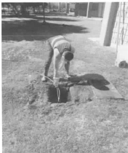
SONDEO Y DESAZOLVE DE RED SANITARIO.
