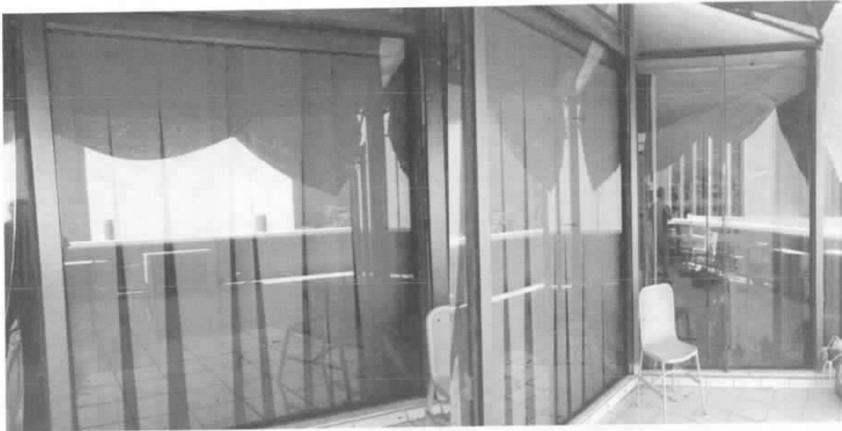
SUMINISTRO Y COLOCACION DE CRISTAL.
