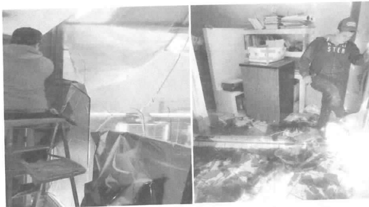
DESMONTAJE DE VIDRIOS, CRISTALES
