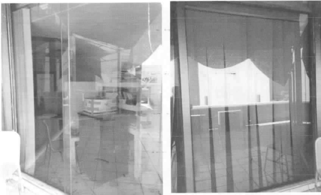
SUMINISTRO Y COLOCACION DE CRISTAL CLARO DE 6MM. DE ESPESOR.
